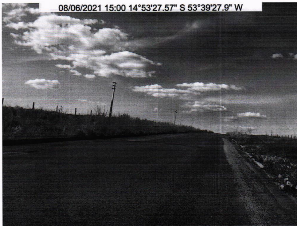
FOTO 17: VISTA GERAL DO TRECHO - km 11,3
