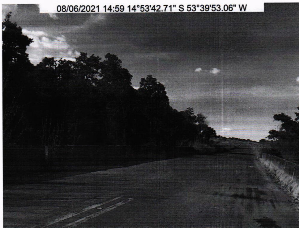
FOTO 18: VISTA GERAL DO TRECHO - km 12,1
