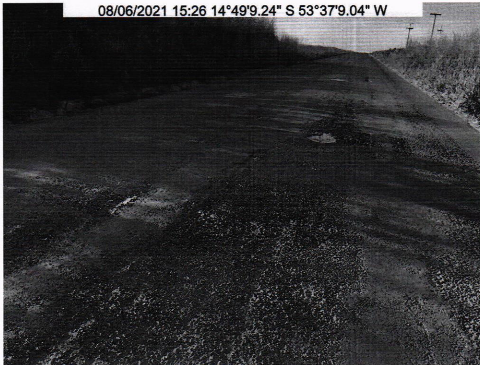
FOTO 4: VISTA GERAL DO TRECHO - km 1,1
