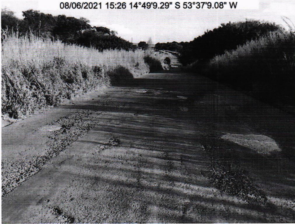
FOTO 3: VISTA GERAL DO TRECHO - km 1,1
