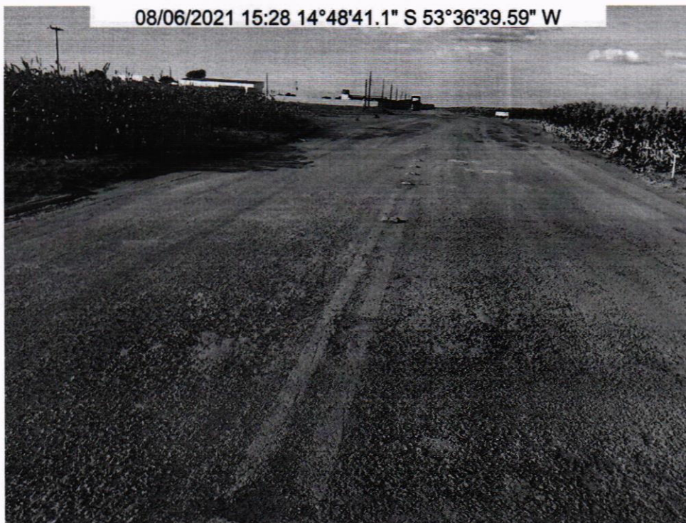
FOTO 1: VISTA GERAL DO TRECHO - km 0,1
