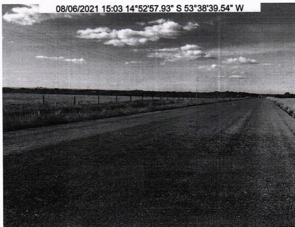
FOTO 16: VISTA GERAL DO TRECHO - km 9,5
