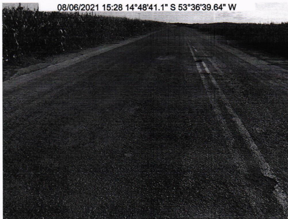
FOTO 2: VISTA GERAL DO TRECHO - km 0,1
