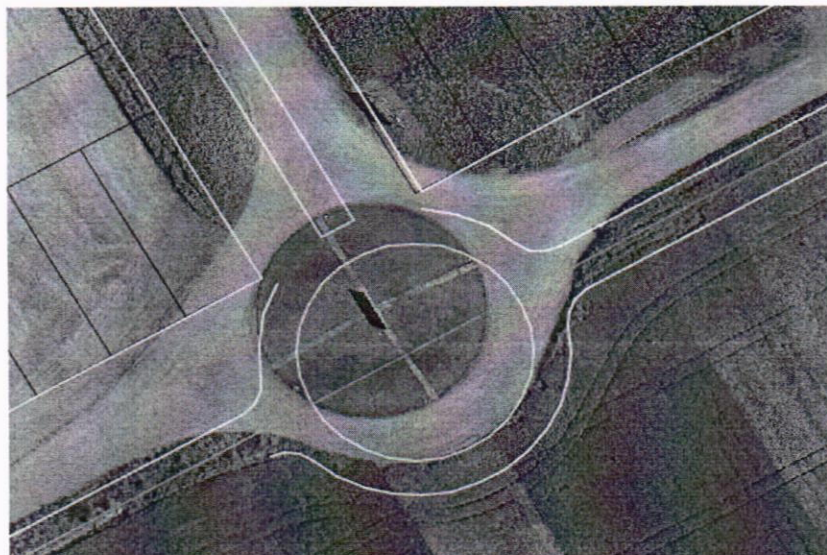
Pavimentação rotatória – 2.287,00 m 2
