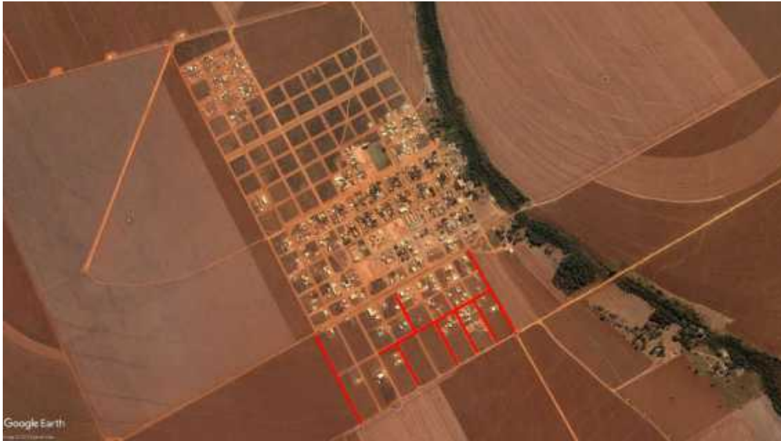
Ruas que receberão pavimento em Santo Antônio do Leste
