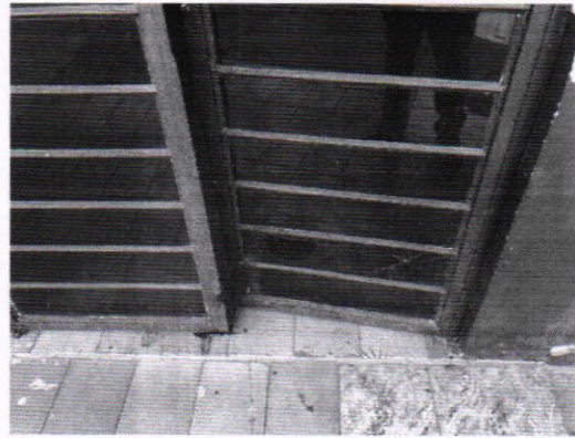
Figura 04 – Porta de Acesso
