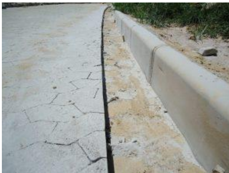
Assentamento dos Blocos Intertravados em Curvas
